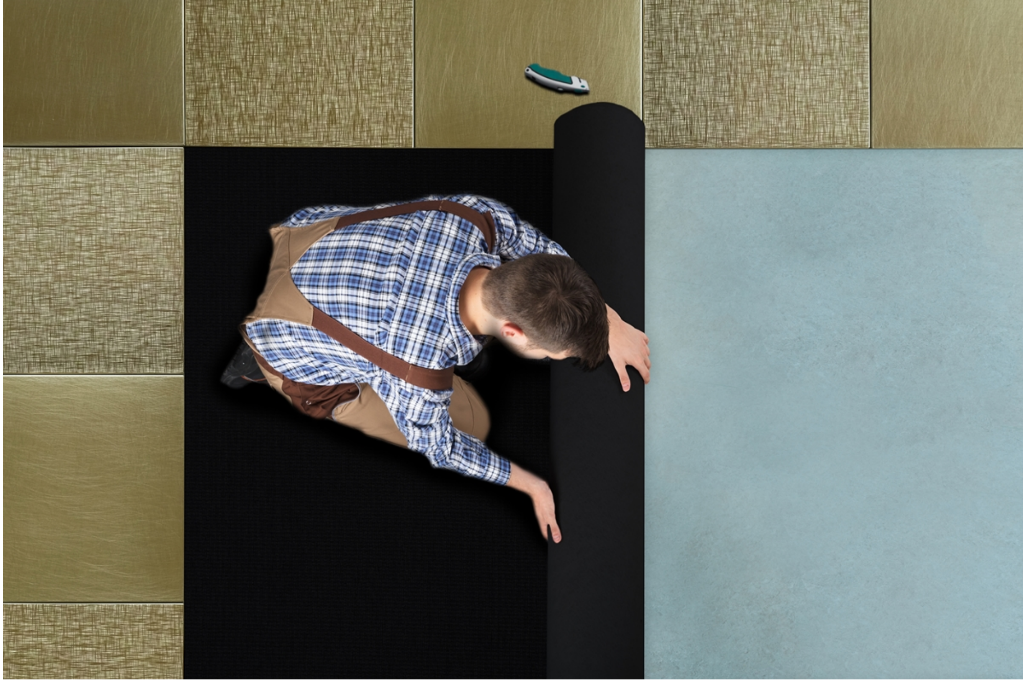
Consentono pose veloci a secco, in rispetto dell'ambiente, con semplice appoggio oppure con agganci brevettati meccanici o one-click tra piastrella e piastrella, o ancora pose tradizionali a colla.
